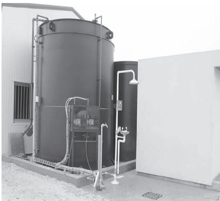
Foto 61: Tanque de reactivo con las bombas volumétricas
