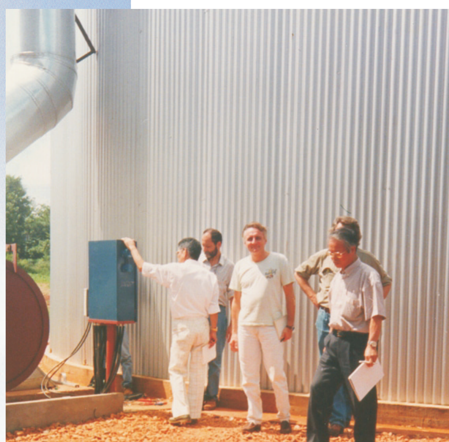
Evaluación de instalaciones eléctricas en una planta industrial.
