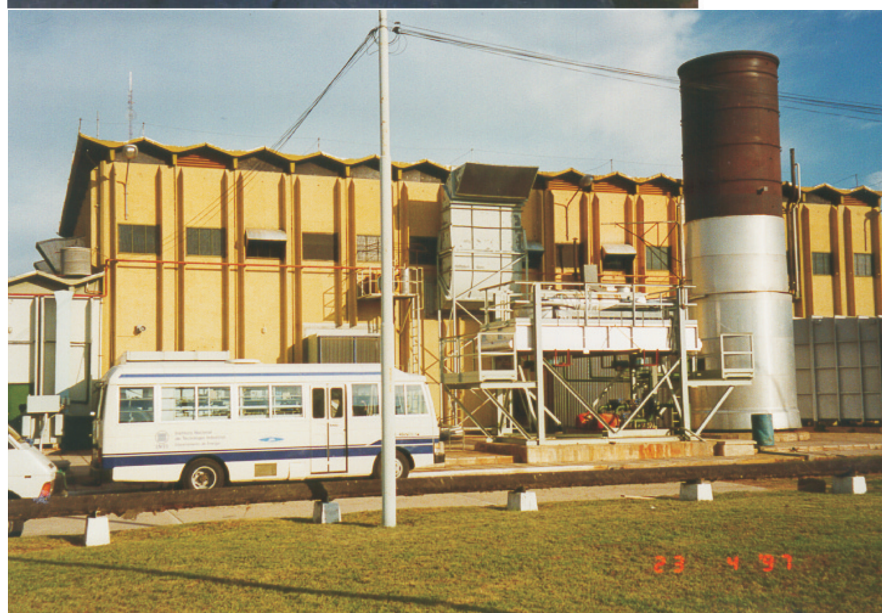
Trabajos en centrales térmicas de generación eléctrica.
