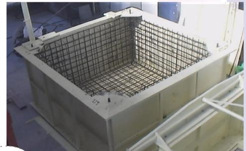
Molde. Paredes externas y armadura
