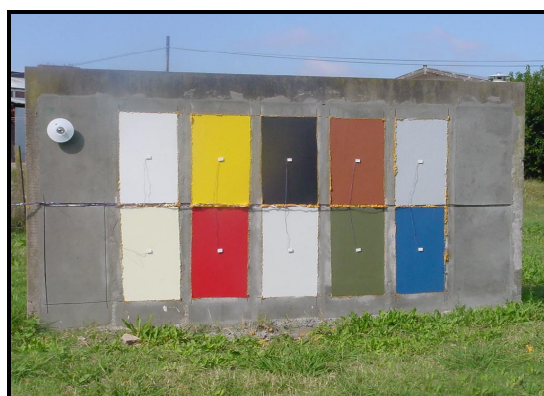
Fig. 1: Muro sobre el que se realizaron las mediciones de temperatura superficial.
