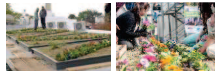
Cubierta viva sobre techo de chapas Municipalidad de Alta Gracia. Colectivo TABIUNC Estudio Van-Gross.
