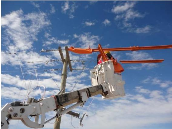
Figura 2. Prácticas de TcT. Cambio de seccionador unipolar.
