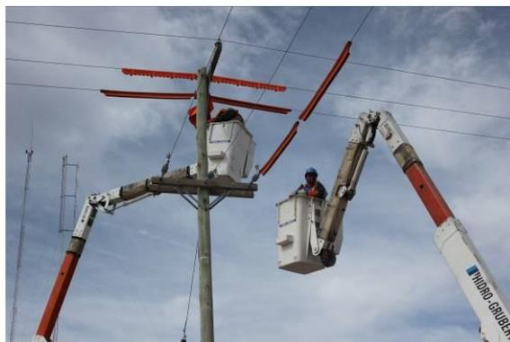
**Figura 1. Prácticas de TcT. Cambio de aisladores a perno rígido.**
