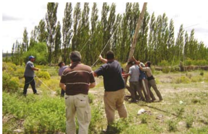
Instalación de una antena en la comunidad mapuche Mariano Solo, Paraje de Colan Conhué.
