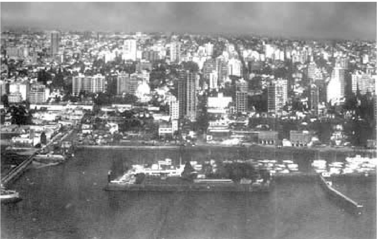
Figura A.2. Ejemplo de terrenos con transición de rugosidad tipo I a tipo IV.
