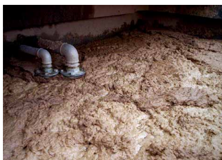
Figura 4: Incremento del espesor del lodo flotado.
