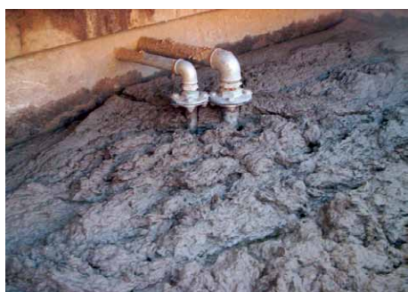
Figura 3: Acumulación de lodo flotado.
