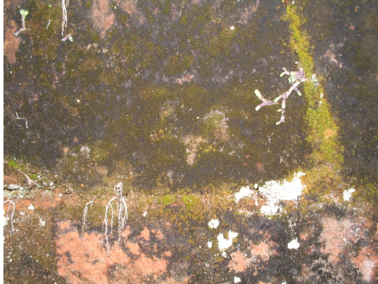
Figura 6: Fotografía de la pared del templo donde puede observarse la presencia de musgos.
