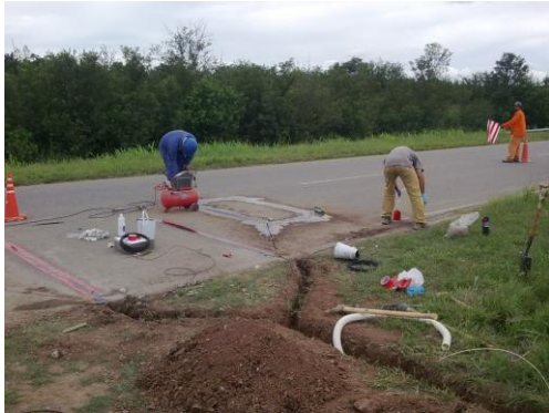
Ilustración 7: instalación de sensores
