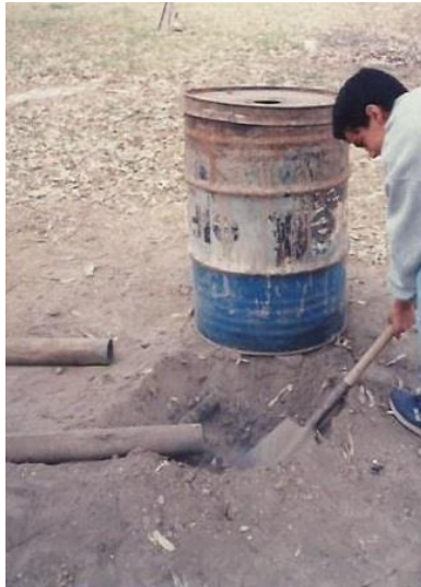
Figura 10. Fotografía in situ del pozo de 40 cm de diámetro x 30 cm de profundidad (Fuente: propia, Santiago del Estero, 2019).
