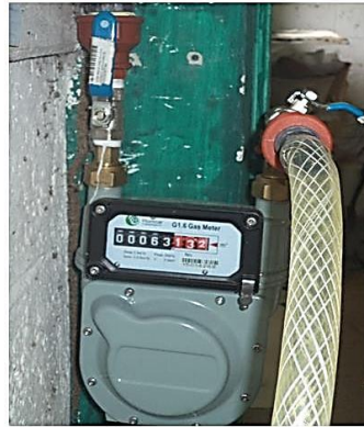
Figura 3. Imagen de gasómetros marca Humcar G 1.6 Gasmeter para registro de generación de biogás. (Fuente: Collahuaso E, 2018, CIPCA, Pastaza, Ecuador).
