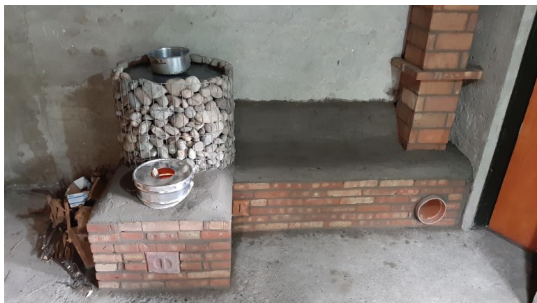
Figura 5. Estufa Rocket Jota construida en el marco del proyecto en El Bolsón (Fuente: elaboración propia).
