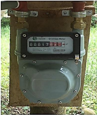
Figura 3. Imagen de gasómetros marca Humcar G 1.6 Gasmeter para registro de generación de biogás. (Fuente: Collahuaso E, 2018, CIPCA, Pastaza, Ecuador).
