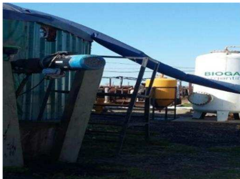
Figura 3. Biodigestor de mezcla completa en Carlos Tejedor (Fuente: elaboración propia, Carlos Tejedor, octubre de 2017)
