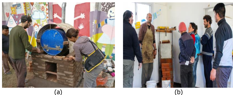
Figura 3. a) Taller de autoconstrucción de horno de tambor y b) Taller de autoconstrucción de estufa PAR (Fuente: elaboración propia).
