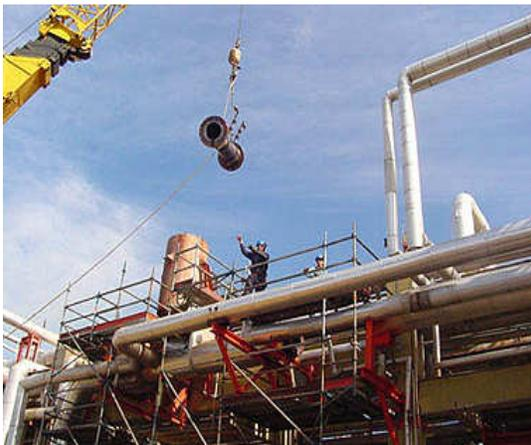
Extracción del tubo Venturi de la instalación mediante el uso de grúa
