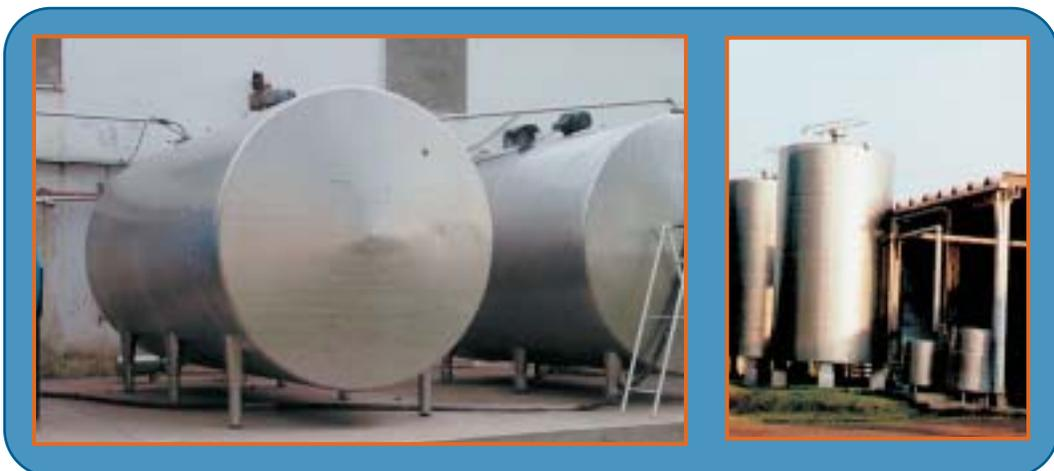
●● Tanque horizontal cilíndrico de acero inoxidable para recepción de leche cruda. Capacidad 10.000 litros.
