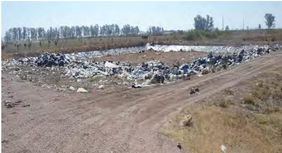
Figura 12: cava o celda donde se depositan los residuos enterrables
