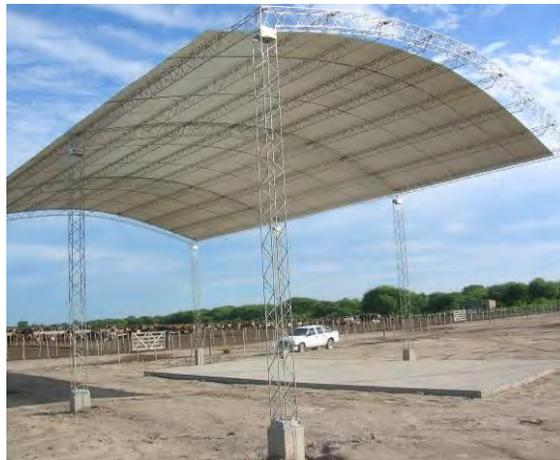
Figura 6: cancha de compostaje con tinglado
