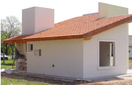
Fig. 2 . Prototipo de VIVIENDA INTI construido con bloques de concreto celular y cubierta tradicional con aislamiento térmico de lana mineral. Tiene baja transmitancia térmica en muros y techos: K=0,69 \text{ W/m}^2\text{K} y 0,58 \text{ W/m}^2\text{K} respectivamente. No posee riesgos de condensación superficial ni intersticial y un beneficio del 37%, en ahorro de energía, respecto a la referencia normativa
