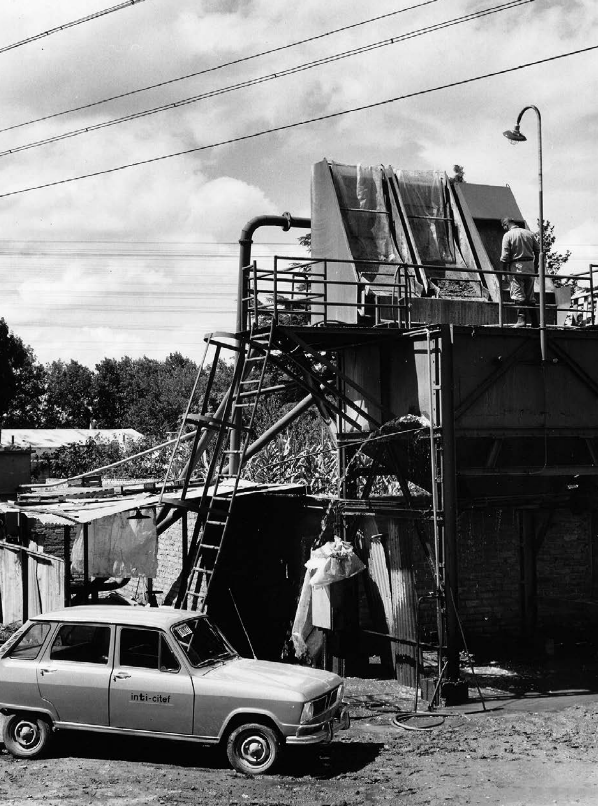
Equipos para el tratamiento de efluentes industriales, Mendoza.
