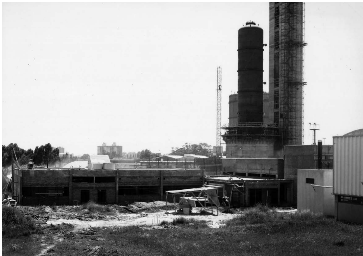
Construcción del Centro de Carnes. Detrás, el acelerador de partículas de la Comisión Nacional de Energía Atómica, en funcionamiento desde 1985.
