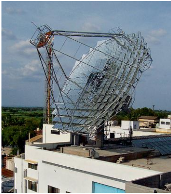
Plato parabólico (Arun dish) en industria láctea de la India. Fuente Clique Solar.
