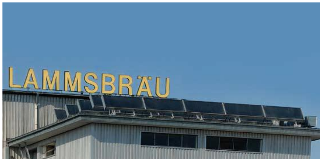
Aire caliente. Maltería Lammsbräu. Alemania.
