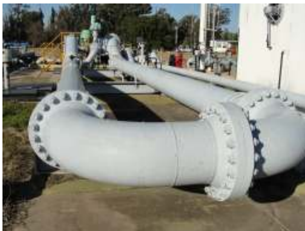
Fig. 3 Probador en U para determinar la constante de calibración del medidor tipo turbina.
