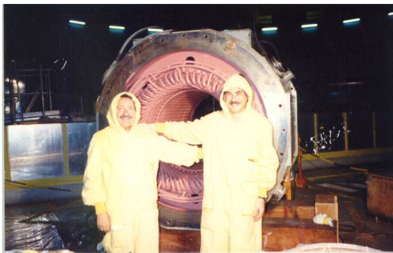
El Ing. José G. Mazzola y el autor en la zona controlada del reactor de Atucha I Atrás, el estator de la bomba del agua pesada de 6,6 kV
