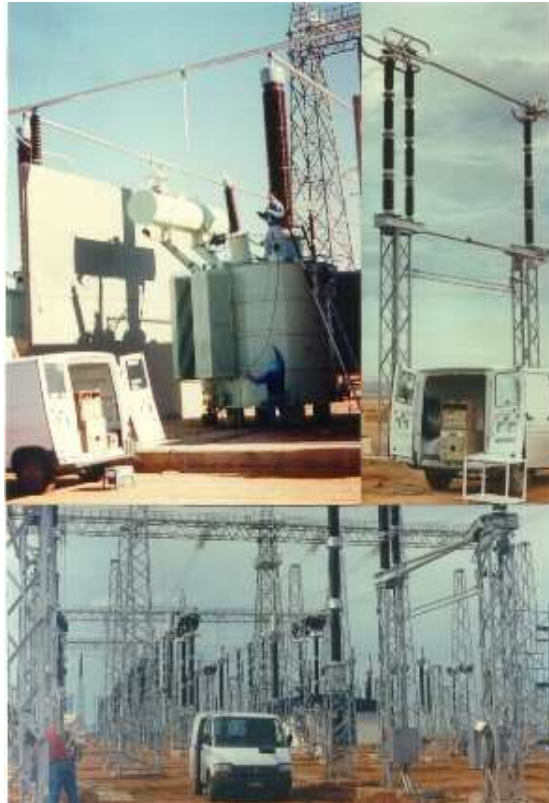
Ensayo de transformadores de medida y reactores de compensación previos a la puesta en marcha de la ET transformadora del Riel Nea (Yacyretá – Resistencia)
