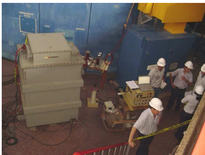
Ensayo de un generador Hidráulico en la Central Edelca – Puerto Ordáz – Venezuela
