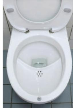
Figura 3: Baño (común) con separación de orina
