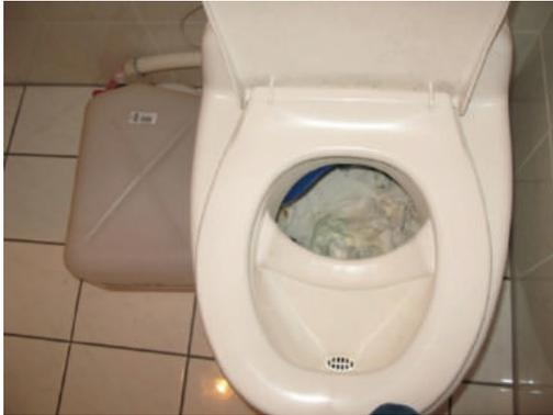
Figura 2: Baño seco con separación de orina
