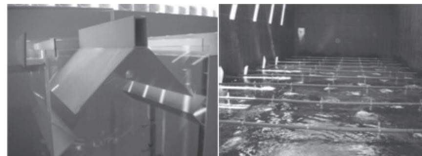
Figura 33. Campana (izquierda) y sistema de distribución (derecha) de un reactor UASB.
