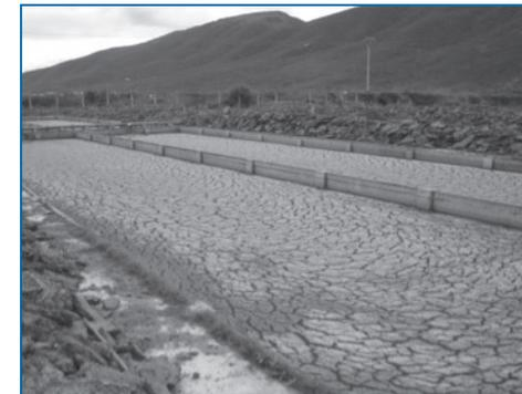
Figura 85. Ejemplo de lechos de secado de lodos anaeróbicos (Salta, Argentina).
