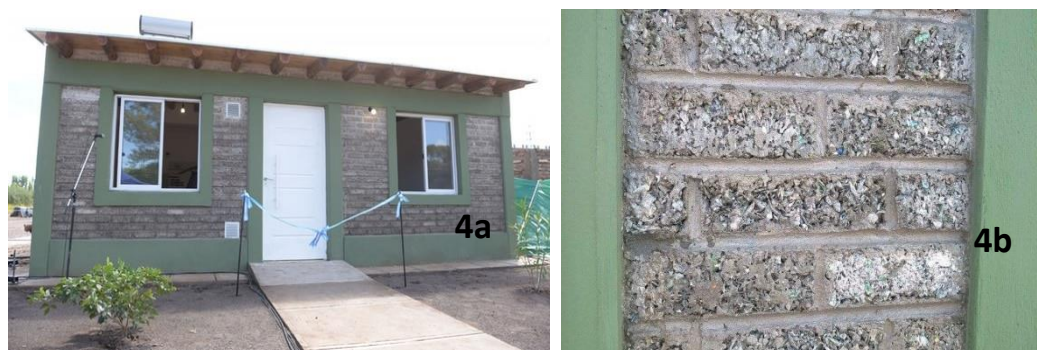
Fig. 4. a. Vivienda construida con ladrillos de PET en Junín de Mendoza.
