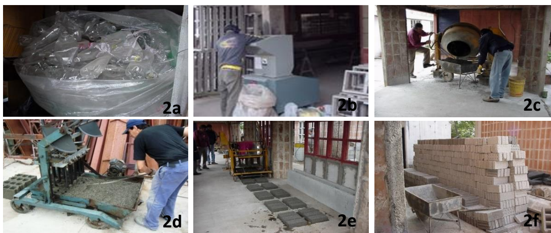
Fig. 2. Proceso de moldeo de ladrillos de PET
