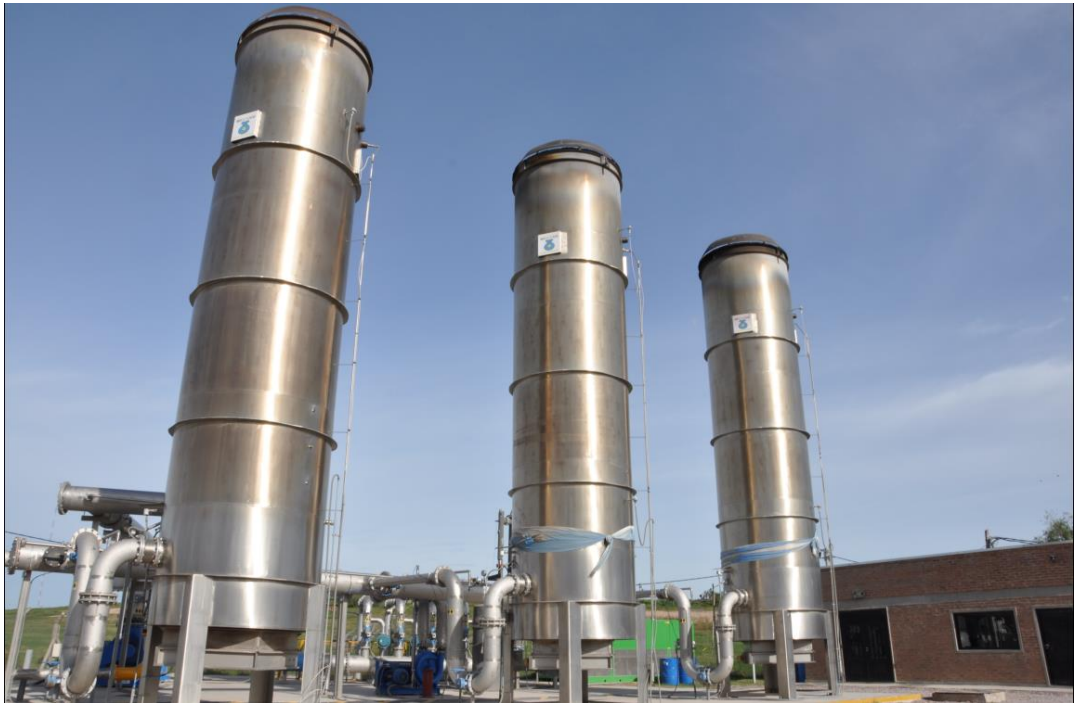
Fig.11. Antorchas de quema de metano en Norte III (fuente CEAMSE)
