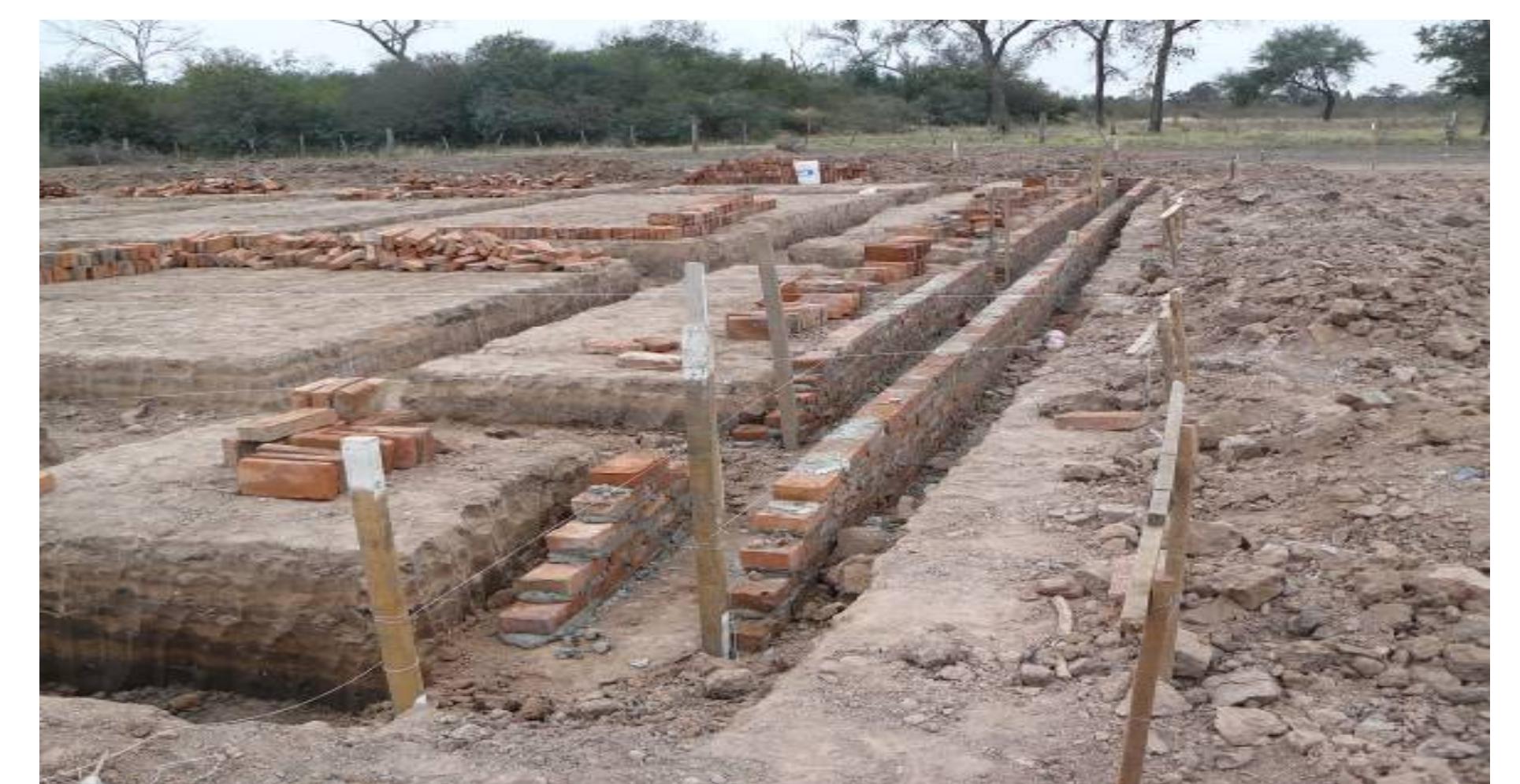
Figura 3 Nivelación de terreno y preparación de platea. Julio de 2011
