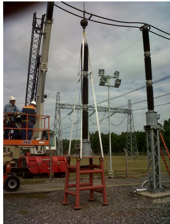
Figura 1. Posicionando TV de referencia 500 kV debajo de la barra
