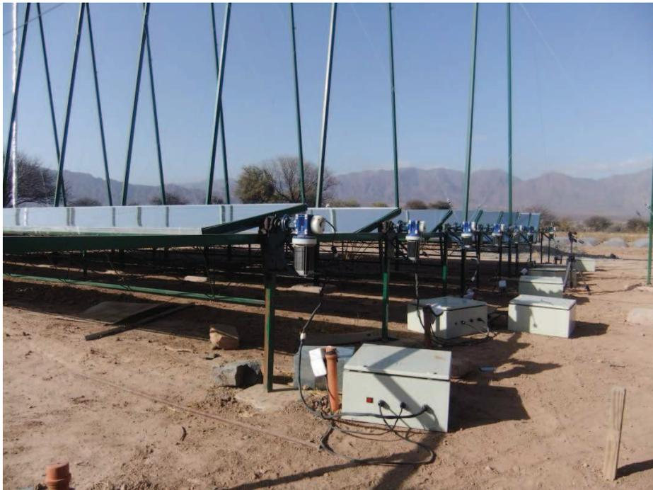
*Figura 6.12: Vista de los espejos con su correspondiente motor y sistema de control*
