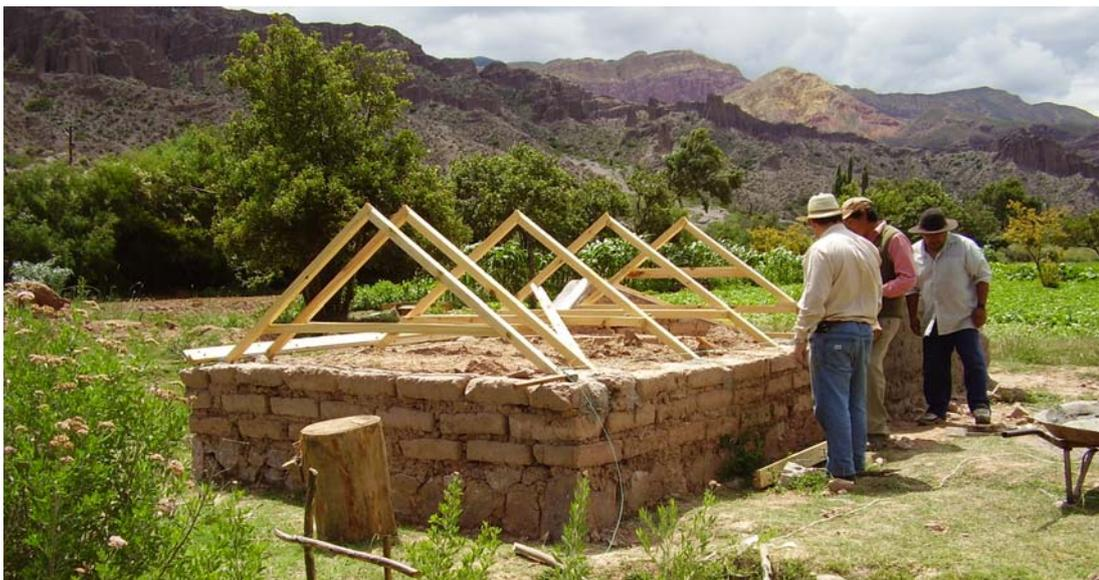
Para montar las cabreadas sobre el muro, se las deben ubicar en las posiciones que se indican en la figura inferior, fijándolas mediante un mortero de piedras, cemento y arena.
