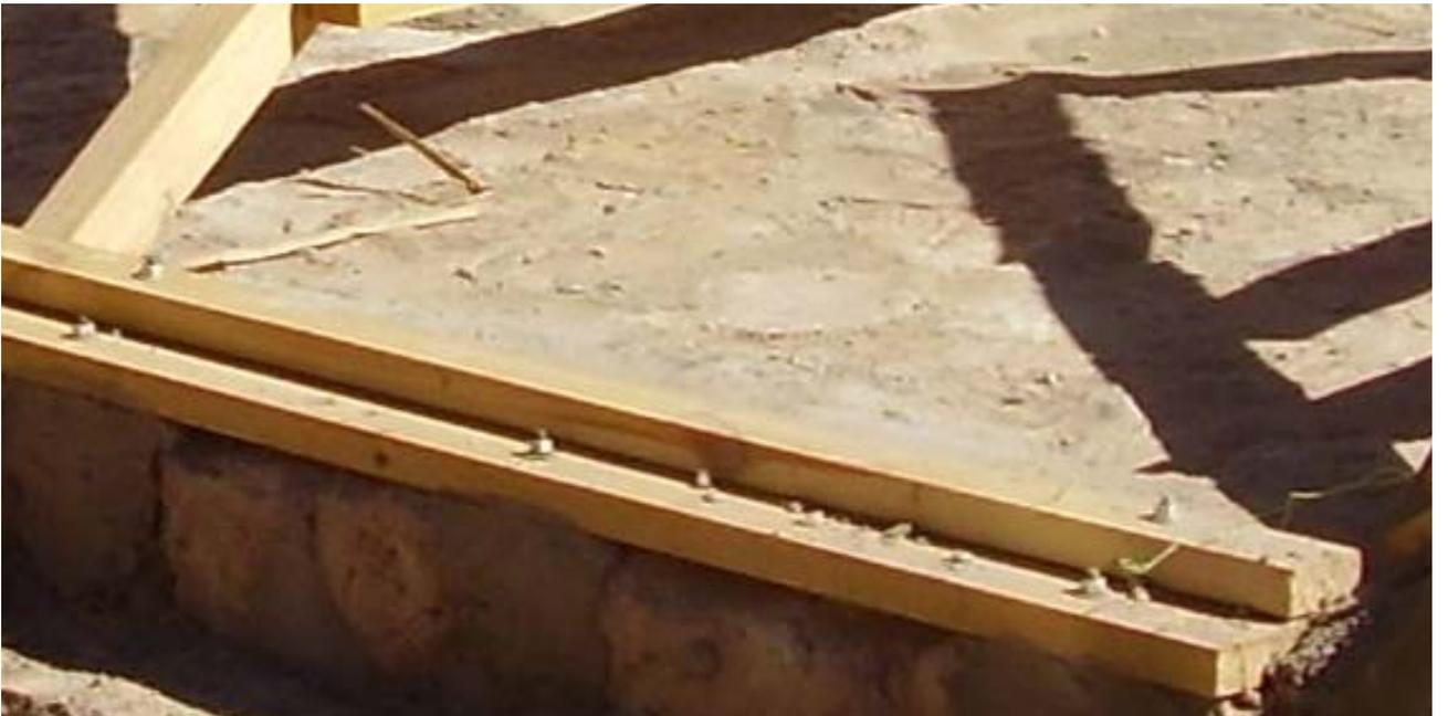
Las fotografías anteriores muestran los soportes laterales que sujetan la cubierta de plástico negro del túnel.
