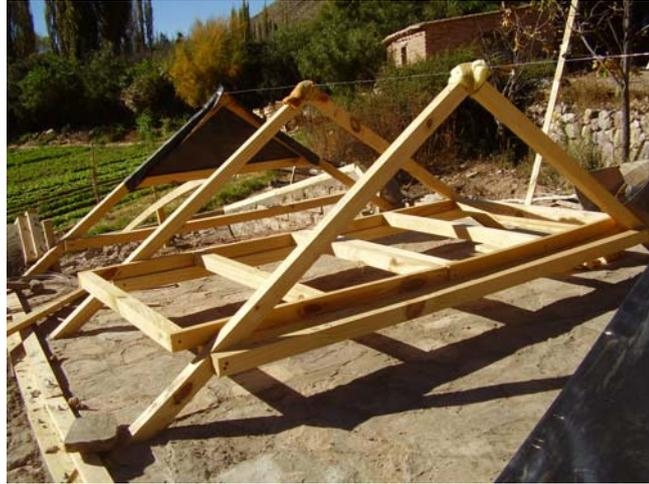
Para proteger el plástico, se cubrirán los vértices superiores de las cabreadas con trozos de espuma de poliuretano, que se fija con cinta de embalaje.
