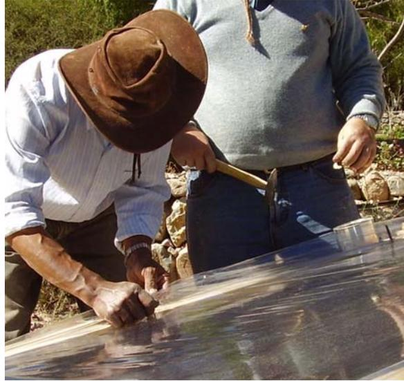
El paso siguiente es colocar el segundo paño, de manera similar al primero. A continuación, se fijan los dos paños a la boca del colector, al soporte de la cabreada Tipo C y a los soportes laterales cortos. A partir de allí, se colocan los prensa plástico en: los laterales (largos y cortos), en la cabreada Tipo C y en el soporte central, asegurándolos con tornillos autoperforantes de 2".
