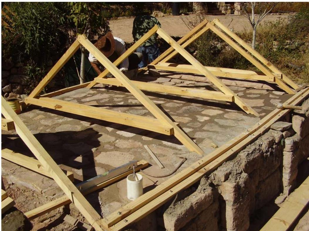
Para sostener el plástico negro del túnel de secado y las bandejas, necesitamos construir una estructura. Ésta, está constituida por las cabreadas.
