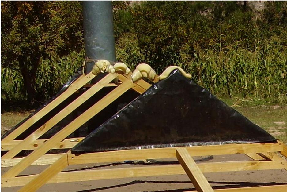
Para el colector se usa plástico transparente de PVC, tipo cristal, de 250  $\mu\text{m}$  (micrones) y 1,40 m de ancho. Se colocará la cobertura en dos paños de 3,50 m de largo cada uno. Para colocar los paños, primero se retiran los prensa plástico laterales. Colocación del primer paño: se debe colocar el plástico desde el centro hacia los laterales. Se tensa el plástico a lo largo del soporte central del colector y se lo fija con tachuelas y trozos de cartón.
