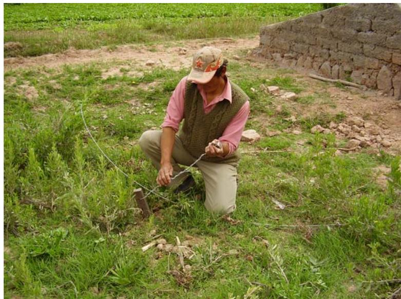
Cuando el terreno es poco firme, se realiza un pozo y se fija la estaca mediante un mortero de piedras, arena y cemento.
