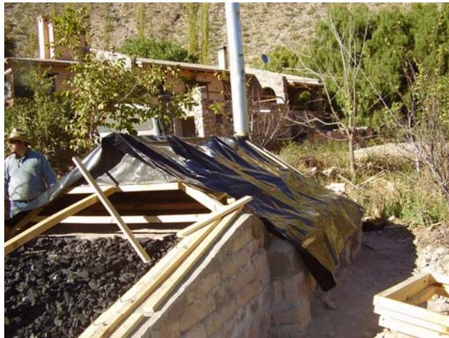
Para fijarlo se lo asegura con prensa plásticos de ambos lados de cada cabreada, que se los construirán de madera de 1" x 2" de sección y 60 cm de longitud. En la parte superior se los colocará fijos, atornillándolos con tornillos autoperforantes de 2".
