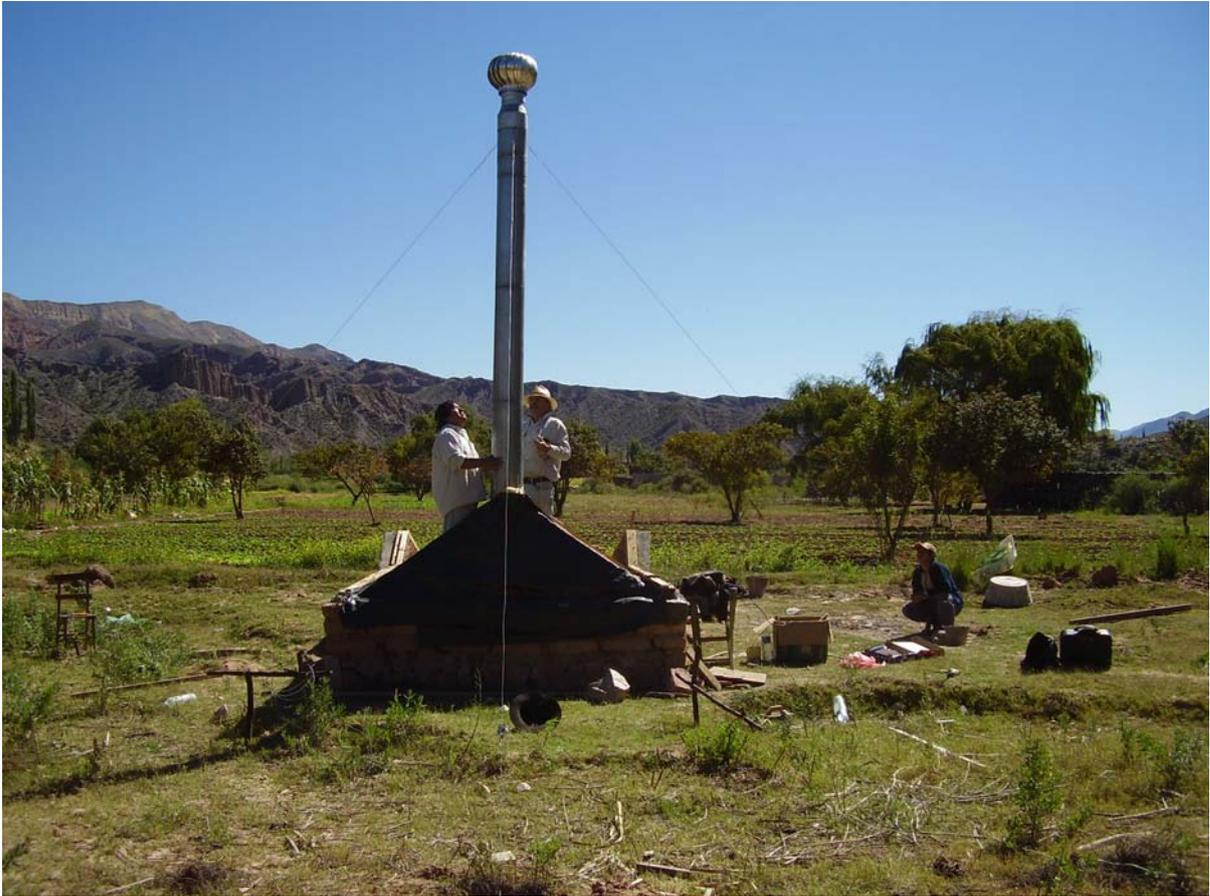
Tensados los vientos, de forma tal que la chimenea ("a ojo") quede en posición vertical, se la fija a las cabreadas mediante tornillos autoperforantes de 3", colocando unos tacos de madera en el interior del tubo, para proteger la chapa.
