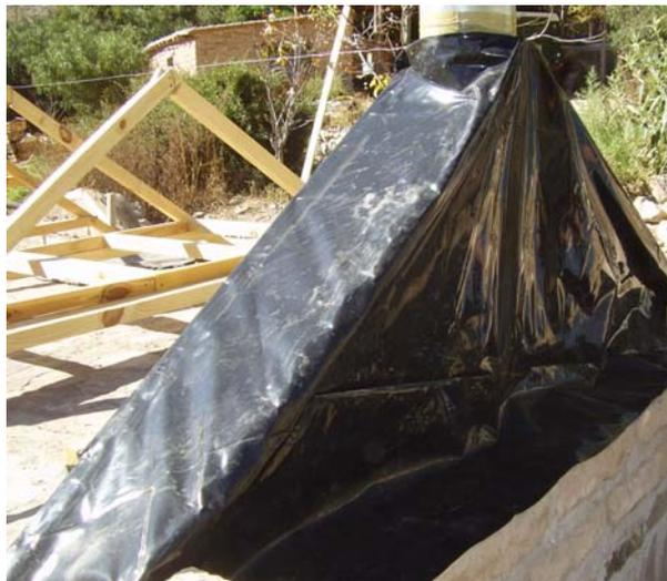
Para colocar el plástico, debe realizarse un pequeño corte que permita "envolver" al tubo de la chimenea y asegurarlo con cinta de embalaje. Luego se confecciona un suncho con un trozo de espuma de poliuretano (10 cm x 70 cm), forrado con retazos de plástico negro que se coloca, a modo de cinchón, cubriendo el acople del plástico con el tubo y asegurándolo con dos abrazaderas de alambre de fardo.
