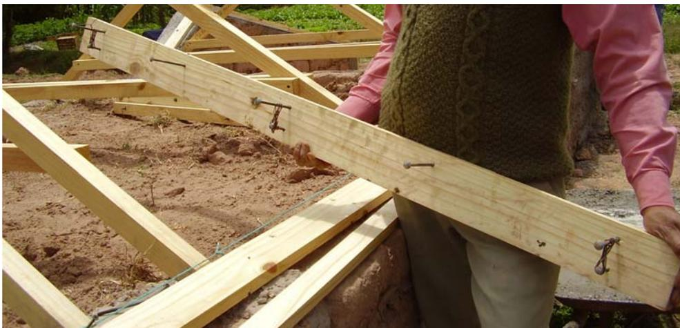
Estos soportes deberán fijarse al muro mediante bulones de cabeza semiesférica con cuadrante, cincados, como los que se usan en la construcción de portones rurales.
