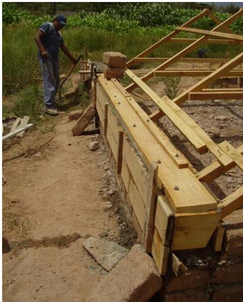
Cuando el mortero del encofrado ha fraguado, será necesario completar el relleno de tierra, arena, grava o piedra hasta tres o cuatro centímetros del borde del muro en el sector del túnel. Luego se procede a realizar una carpeta con un mortero pobre o al enlajado.
