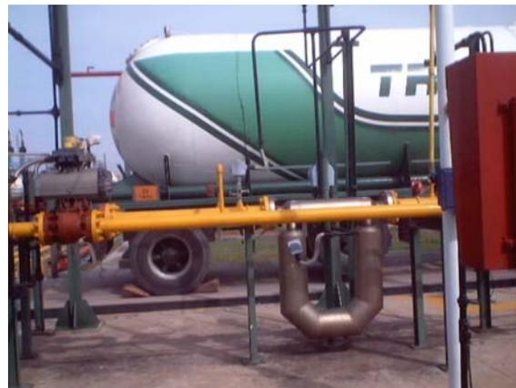
Fig.3 Medidor másico y camión tanque para transporte de GLP.
