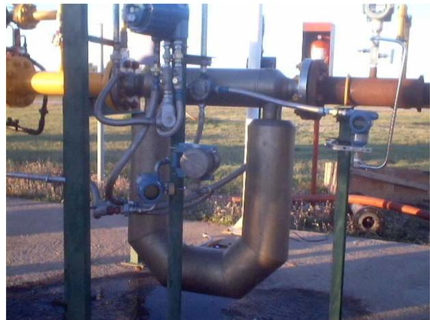
Fig.2 Medidor másico por efecto Coriolis e instrumentación asociada.
