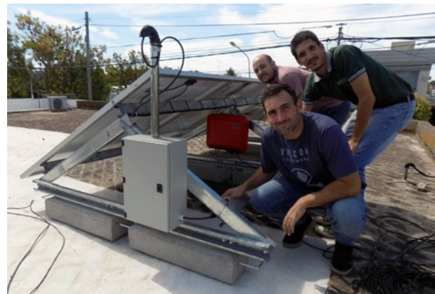
Instalación del primer equipo fotovoltaico del proyecto PRIER.
