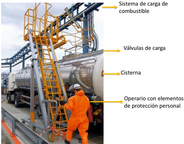
Figura 1. Carga de un camión cisterna de combustible
