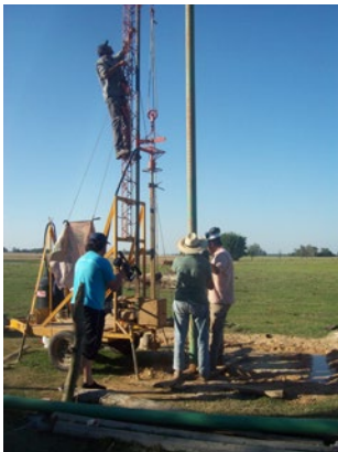
Foto 1: Perforación mecánica con método Rotary
