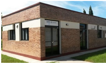
Laboratorio de ambiente de 60 m 2 finalizado.
