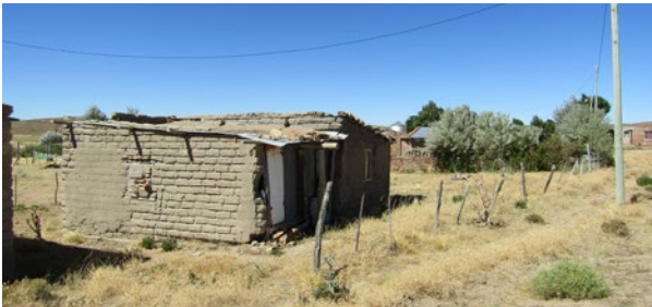
Figura 1: Viviendas de Laguna Blanca.
