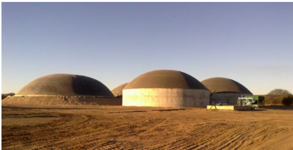
Figura 1: Planta de Biodigestión Anaeróbica – Mezcla completa
