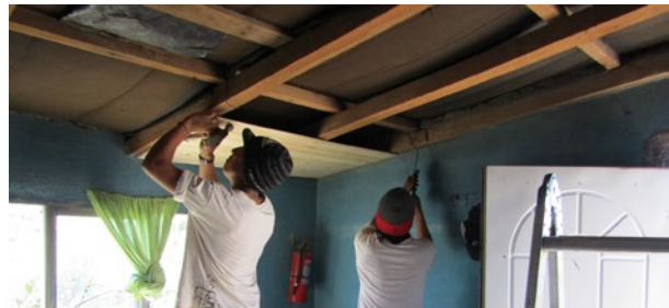
Figura 4: aplicación de fibras para su aislación.
