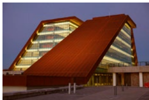
Fotografía 1: Edificio de descentralización administrativa "Terrazas del Portezuelo" San Luis, Argentina
