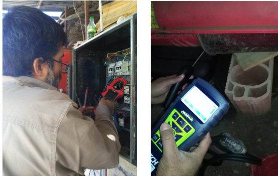
Figura 2: Medición de consumo eléctrico y de gases de combustión.
