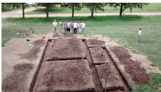
Figura 2. Construcción de sala faena de pollos. IAS Nuestra Señora del Rosario, Colonia Vignaud, Córdoba.
