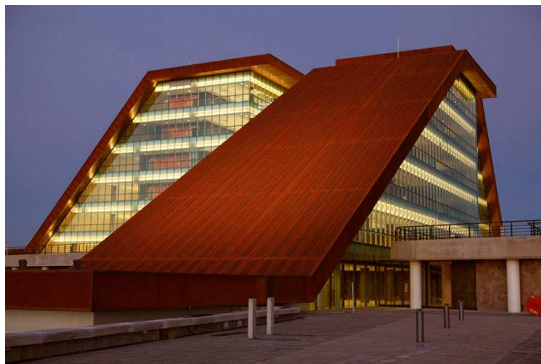
Figura 1: Edificio de descentralización administrativa "Terrazas del Portezuelo", San Luis, Argentina
