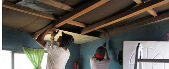
Figura 4: aplicación de fibras para su aislación.
