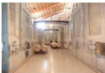
Las resinas epoxi se utilizan como revestimiento interior de vasijas vinarias de hormigón destinadas a contener mosto o vino a granel.
