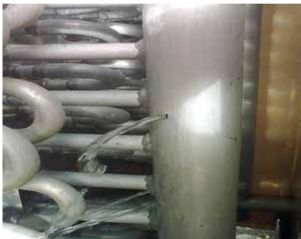
Figura 1: Pérdida de agua en intercambiador de calor
