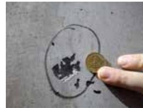
Figura 3. Verificación del aspecto superficial: oquedades y fisuras inadmisibles.
