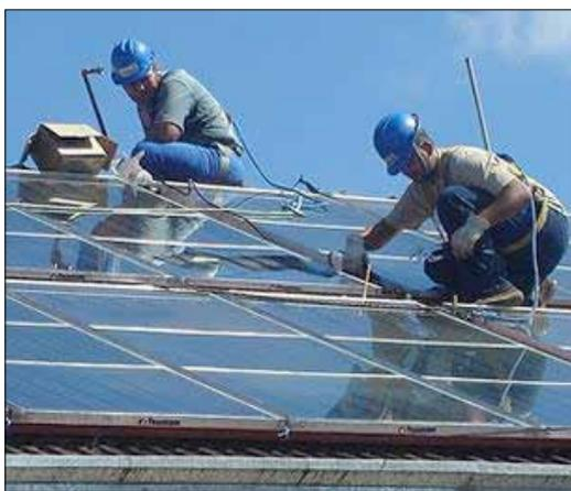
Figura 1. Instalación de sistema solar térmico.
