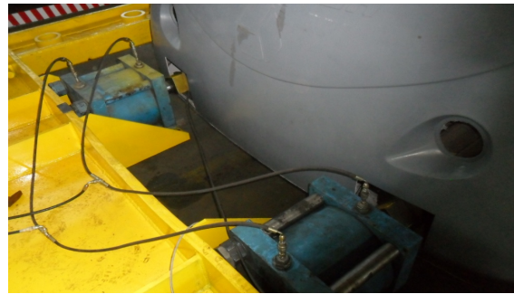
Figura N°8 – Posición de gatos hidráulicos
