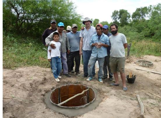
**Figura 2:** Capacitación en la construcción de pozos excavados y calzados con hormigón.
