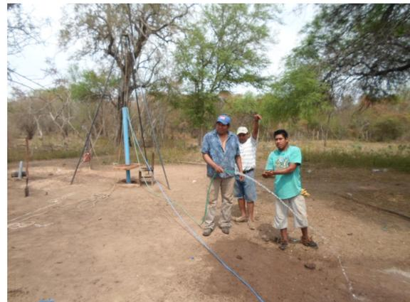
**Figura 2:** Pozo perforado por miembros de la comunidad durante la capacitación, equipado con una electrobomba sumergible.
