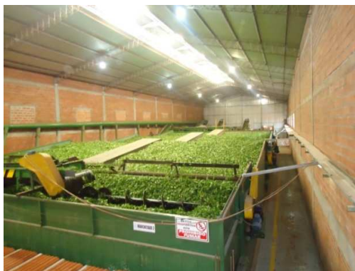
Figura 2: Mejoras edilicias de un secadero de Te para asegurar la inocuidad del producto. Ejemplo: luces con protecciones, cierre de ventanas abiertas que comunicaban la planta con el exterior.
