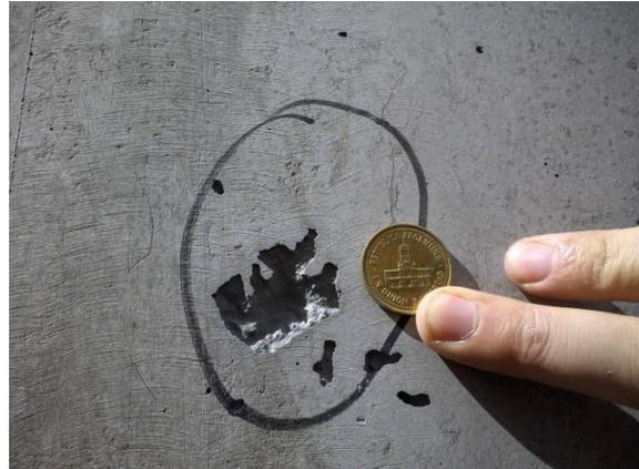
Figura 5: Verificación del aspecto superficial: Apariencia de Oquedades y Fisuras inadmisibles.
