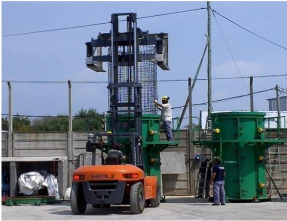
Figura 4: Procedimiento de colocación de las armaduras dentro del molde previo al moldeo
