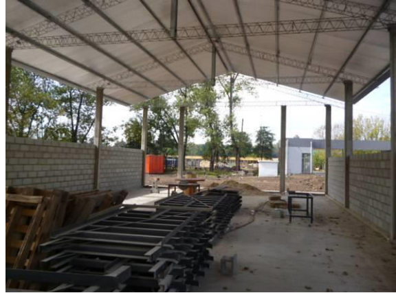
Figura 1: Estado inicial del galpón para planta de bloques
