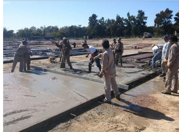
Figura 5: Utilización de hormigones por cooperativas de trabajo
