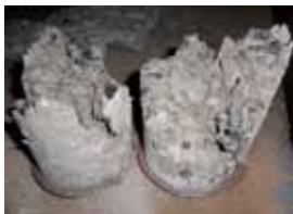
Figura 5. Tipo de rotura.
