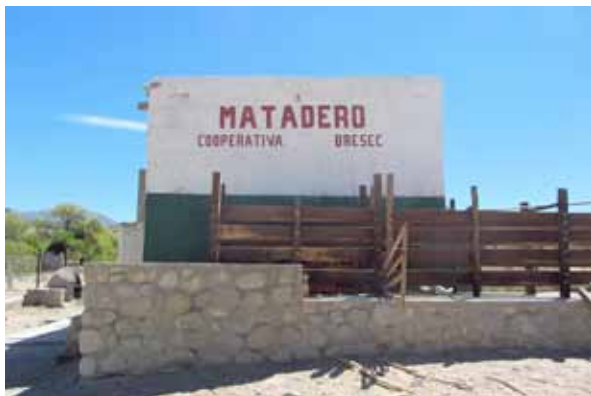
Figura 2. Vista frontal de la planta de faena Seclantás.
