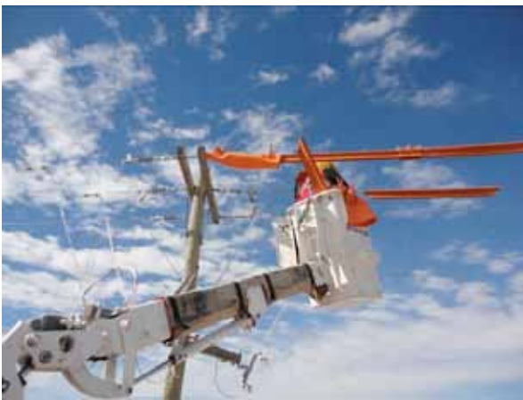
Práctica de cambio de aislador de perno rígido en línea de media tensión.
