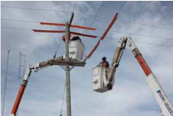
Práctica de cambio de aislador de perno rígido en línea de media tensión.
