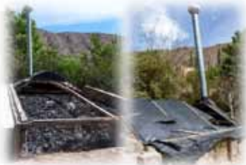
Junto a los productores de la Quebrada de Humahuaca se desarrolló el secador solar Aureliano Buendía. En la foto, el secador instalado en Tilcara.
