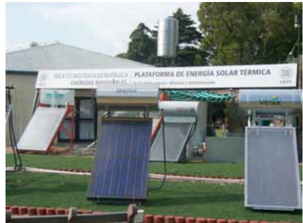
Figura 1. Equipos solares térmicos en la plataforma solar del INTI. Se observan equipos con cubiertas de vidrio o con policarbonato alveolar
