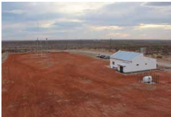
Vista aérea del laboratorio.
