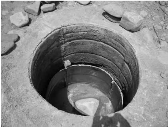
Figura 2: Foto del primer metro revestido con hormigón y el segundo metro con el encofrado.
