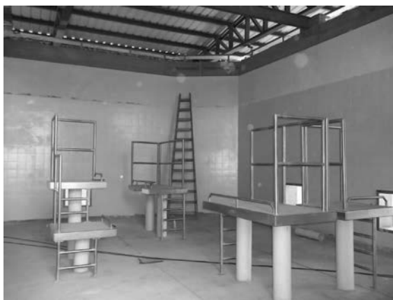
Figura 6: plataformas de trabajo para plantas de faena de vacunos montadas en la obra.
