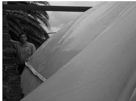
Figura 2: gasómetros que contienen el biogás producido en la planta de ADCADIS, aproximadamente 20 m 3 .
