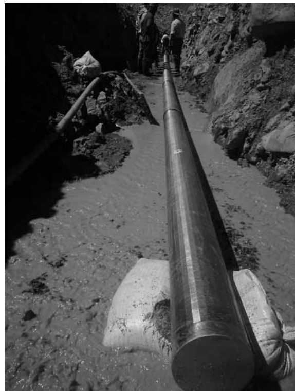
Figura 1: filtro de acero inoxidable, de abertura 0,75 mm.
