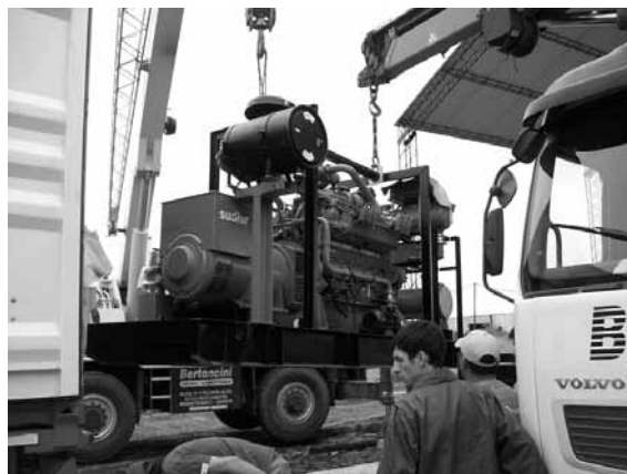
Figura 2: descarga del generador de 250 kW.
