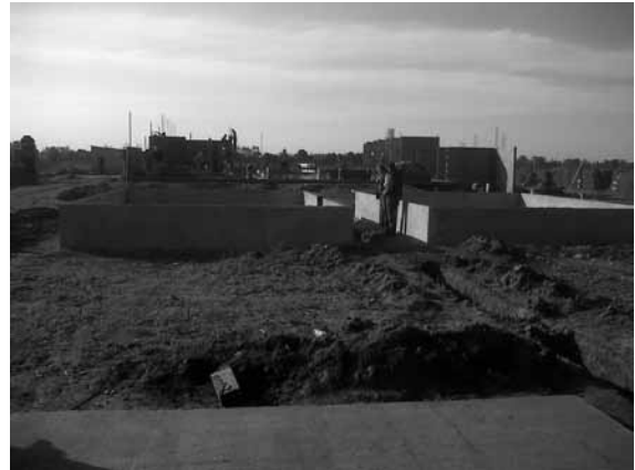
Figura 5: construcción del frigorífico de Bella Vista, Tucumán. Contrafrente.
