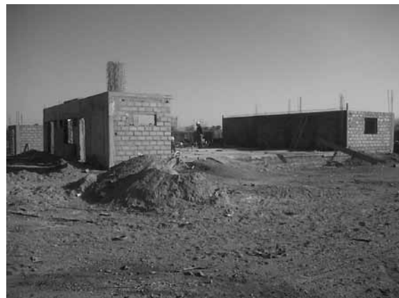
Figura 6: construcción del frigorífico de Bella Vista, Tucumán. Frente.
