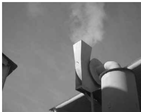
Figura 4: salida lavador de humos.
