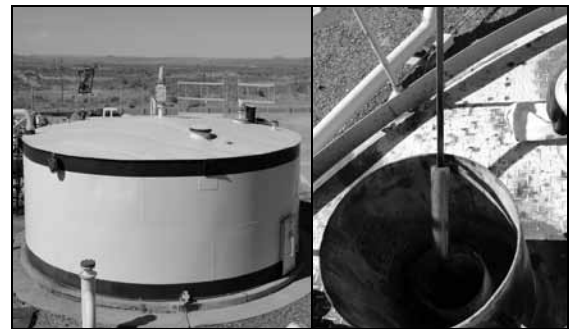
Figura 3: tanque quieto. Control con varilla.
