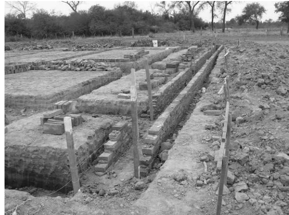
Figura 3: nivelación de terreno y preparación de platea. Julio de 2011.
