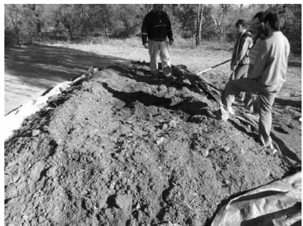
Figura 4: armado y primer relleno del pisadero.
