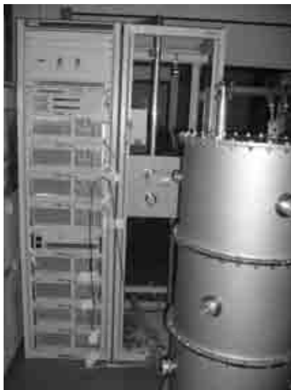
Transmisor de TV digital de 1 kW de potencia con su respectivo filtro
