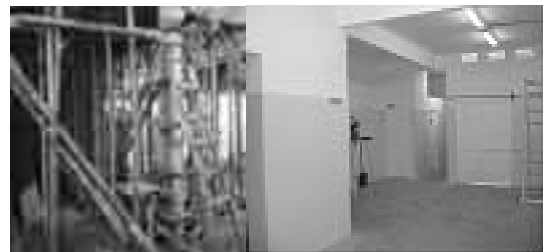
Planta en construcción
