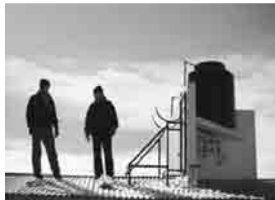
Instalación de soporte según propuesta
