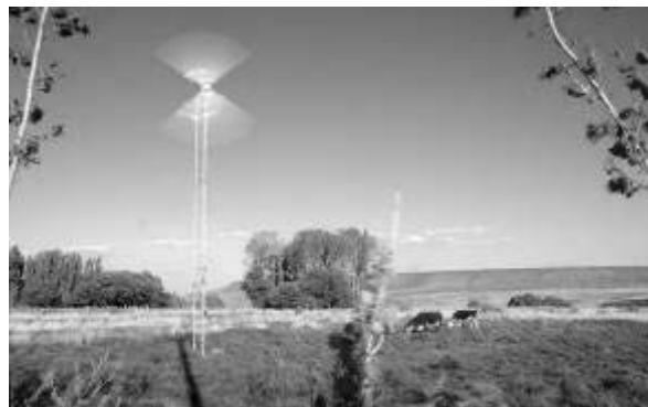
Unidad de experiencia piloto de generación de energía y extracción de agua
