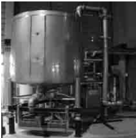
Tanque para pesaje de 3 m 3 en proceso de montaje
