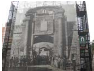
A.T. para la restauración de la Puerta de la Ciudadela en Montevideo
