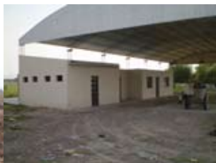
Planta en Construcción
