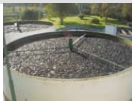
Tratamiento con Filtros Biológicos
