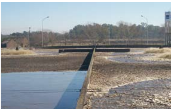
Tratamiento con Reactores Biológicos con Aireación
