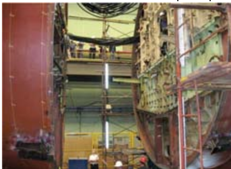
Corte y separación del casco del submarino S-42 ARA San Juan
