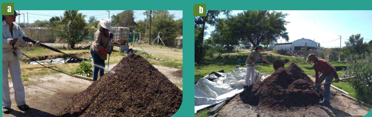
**Figura 13.** Monitoreo de las pilas de compost durante el ensayo de compostaje en la Planta de Tratamiento de Residuos Sólidos Urbanos de Unquillo, Córdoba: a. Riego y b. Volteo.
