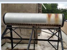
Equipo de EST de tubos al vacío, montado sobre el techo de una vivienda, en proceso de desmontaje por pérdidas de ACS en el acumulador.
