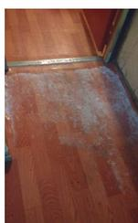
Piso de la Base con escarcha debido a la deficiente aislación térmica
