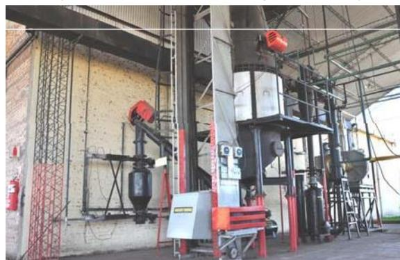
Imagen 1 - Planta demostrativa de gasificación de biomasa INTI para generación eléctrica (250kW).
