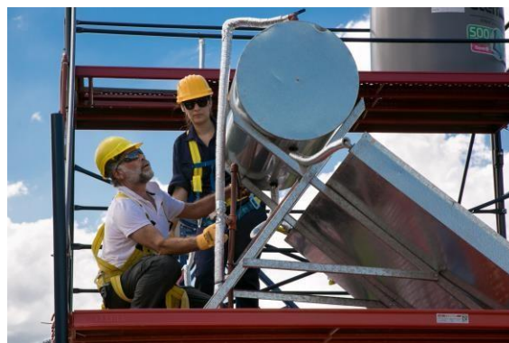
Figura 2: Equipo solar térmico de placa plana.
