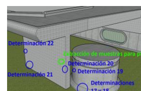
Figura 4. kT 17-22: Bajo puente peatonal Agüero. Medición del espesor de recubrimiento y pH
